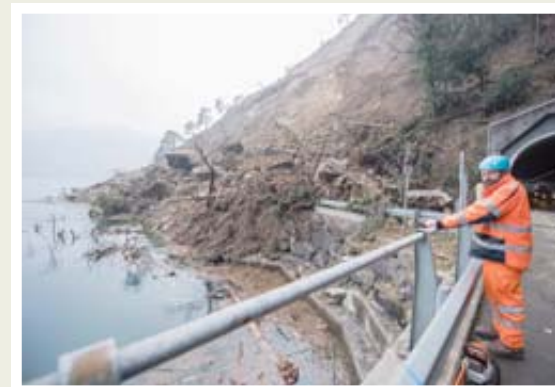
Eboulement Glissement de terrain à l'entrée du tunnel de Schiefernegg. KEY
